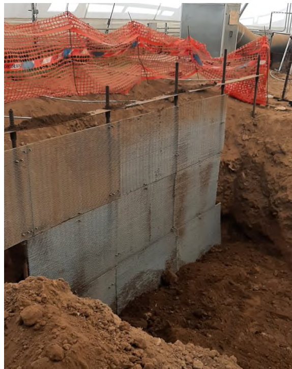
Figura 5 – Fine scavo Trincea n°1 lato nord-est
