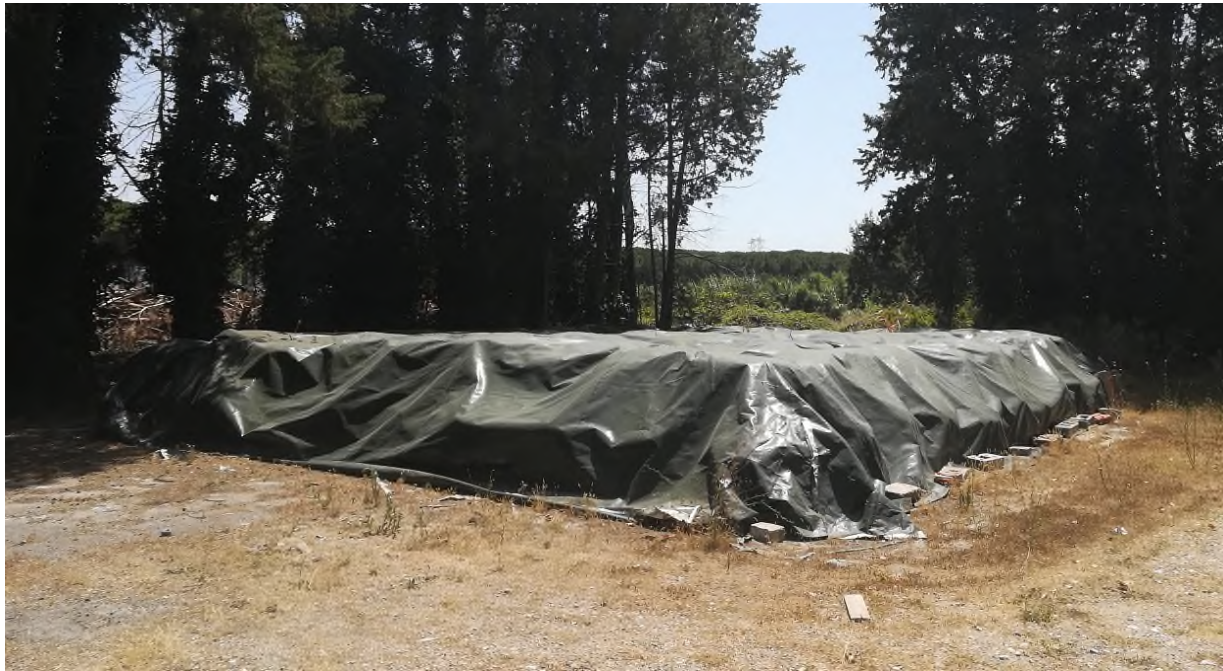
Figura 8 –Big-Bag sotto copertura geomembrana (zona 4)
