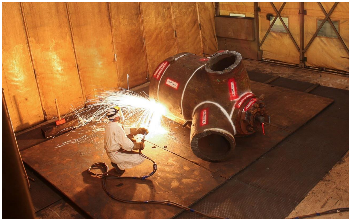
Smantellamento e decontaminazione dei componenti edificio turbina
